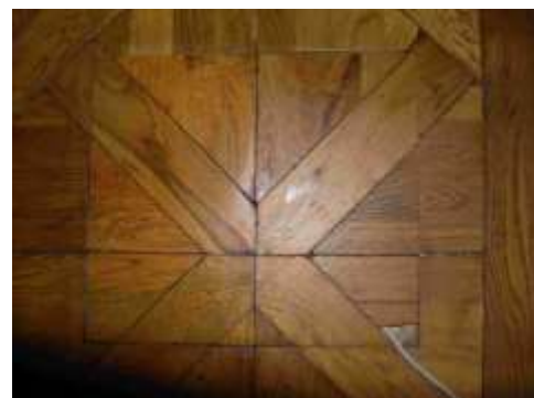
Particolare del pozzetto impianti tecnici mascherato nel pavimento
